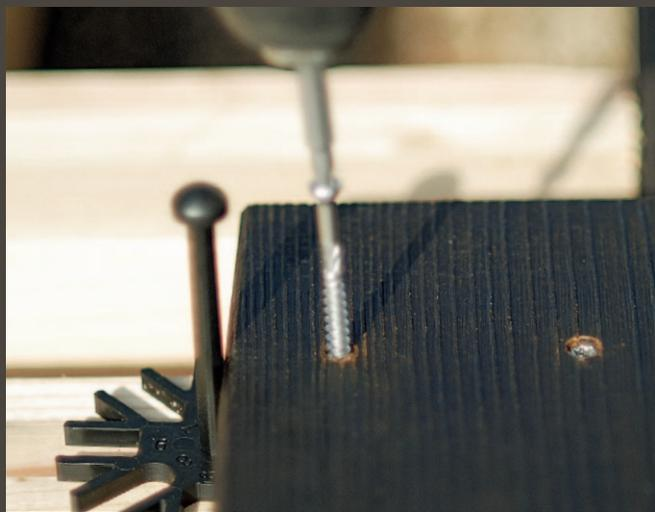
Zusätzlich bietet der Distanzbolzen während der Montage praktische Hilfe zur Schnelleinstellung der Fugenbreite – diese sollte mindestens 7 mm betragen. Selbiger Abstand ist auch beim Zusammenstoßen der Terrassenbretter einzuhalten. Nach fertiger Verschraubung kann der Distanzbolzen wieder entfernt werden. Der TerrassenFix bleibt unter den Brettern als Abstandhalter liegen.
